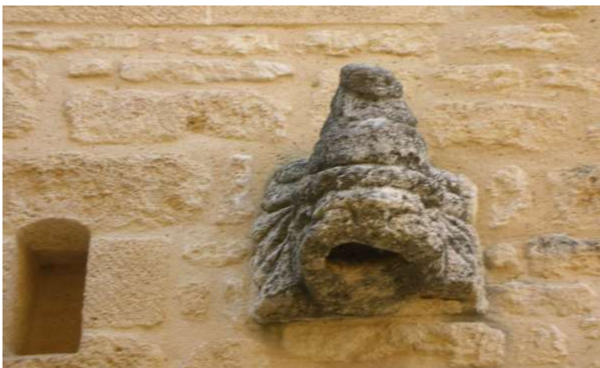
La gargouille en forme de chapeau de gendarme ( signe de justice ) sur la façade de la maison.
